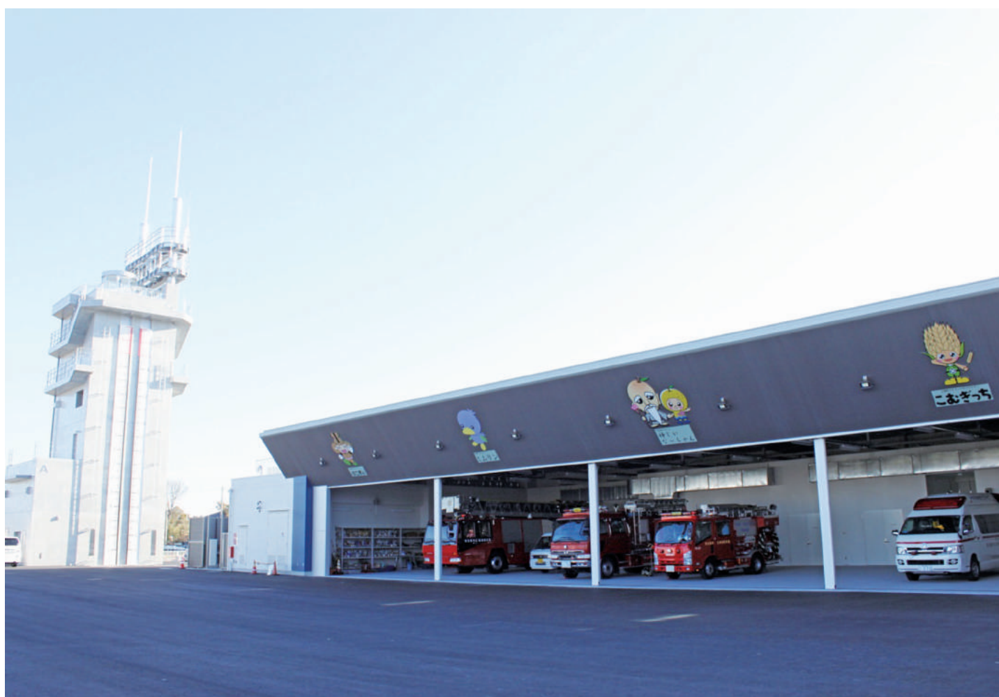
新消防本部庁舎
